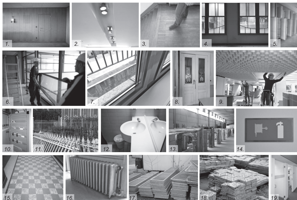
1. Lambris dans un bureau des années '70 ; 2. Luminaires contemporains ; 3. Parquet ; 4. Châssis de fenêtres ; 5. Armoires encastrées contemporaines ; 6. Cloisonnement modulaire, démonté en vue de réemploi ; 7. Double vitrage récent ; 8. Porte ancienne ; 9. Plafond suspendu alvéolaire, démonté en vue de son réemploi ; 10. Tableau électrique ; 11. Ferronneries ; 12. Équipements sanitaires ; 13. Cheminées en marbre ou en pierre ; 14. Signalétique ; 15. Sol en carrelage céramique années '50 ; 16. Radiateur en fonte ; 17. Caillebotis métallique ; 18. Carrelage début xx e siècle ; 19. Portes vitrées.
